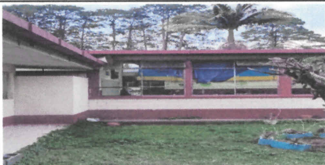
Foto 3: Colocación de base de concreto para tinacos, útiles para la distribución de agua en los servicios sanitarios.
