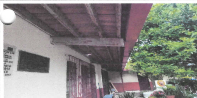
Foto 5: Cambio de techo de teja, necesario por el deterioro de la teja que actualmente tiene.
